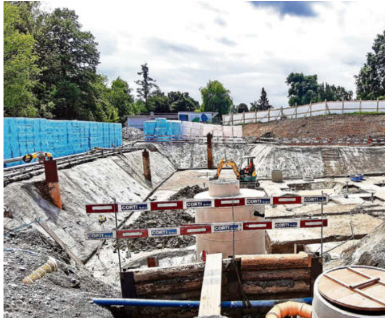
Links im Bild sind die drei Pumpen zu sehen, die nun für eine trockene Baustelle sorgen sollen.
